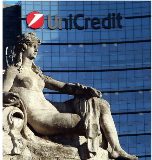
La Torre UniCredit a Milano /Ansa
